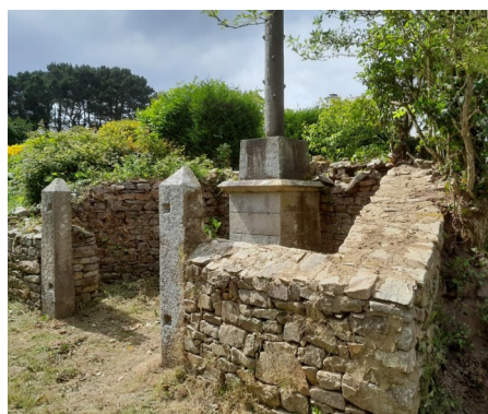
Réfection du mur du calvaire de Kervad
